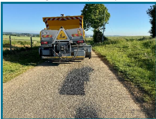
14 tonnes de "point à temps" qui ont été appliquées
