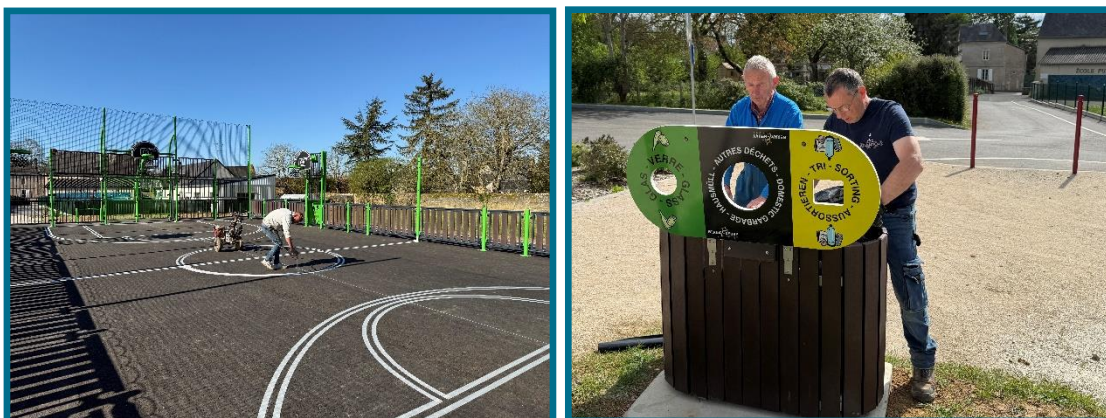
La plateforme multisports a été achevée en avril 2025
