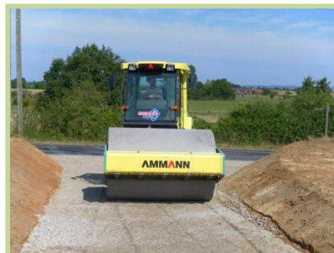
Décapage, rechargement et compactage de la nouvelle sortie du chemin dit "de la chapelle"
