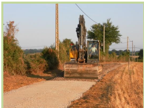
Décapage, rechargement et compactage de la nouvelle sortie du chemin dit "de la chapelle"
